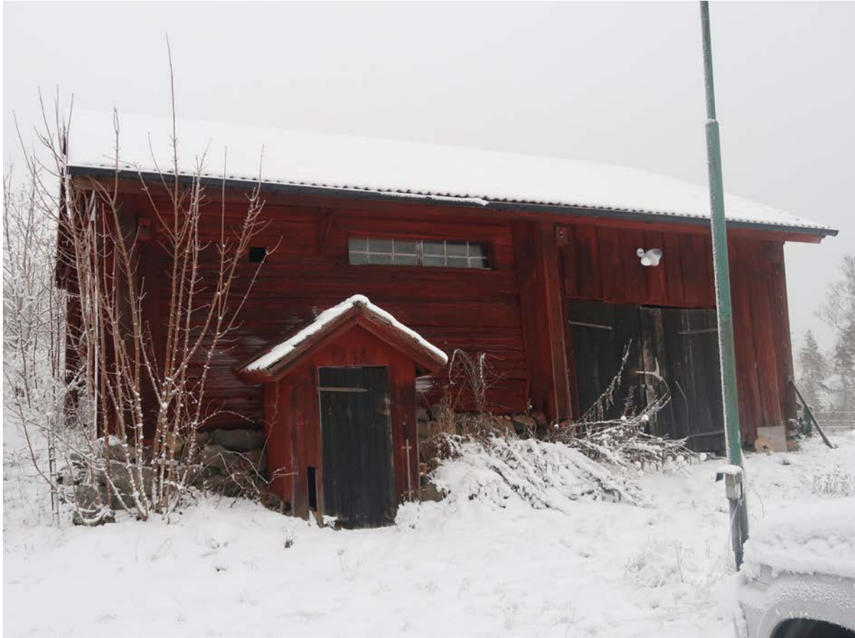
I Björksjön i Hällefors kommun står en envåning loftgångsbyggnad. Byggnaden står på en källare och en loftgång leder in till utrymmena på bottenplan
